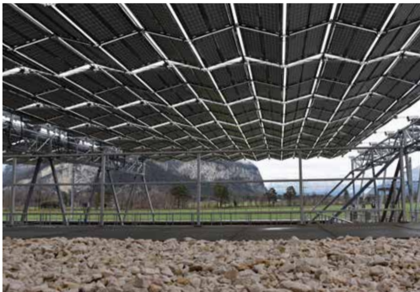
Autark: Die neue und die bestehende Photovoltaikanlage produzieren gemeinsam mit dem Blockheizkraftwerk mehr Strom als die Abwasserreinigungsanlage selbst benötigt.
