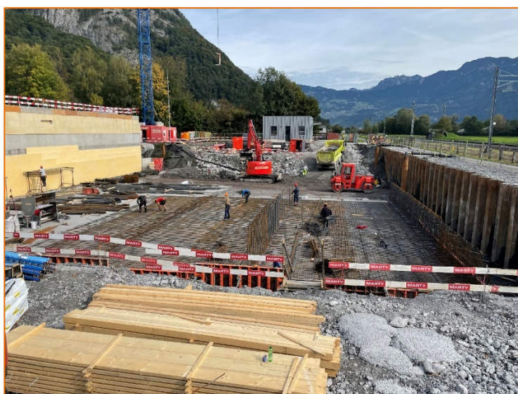
Stand 04.10.2022, Eisenleger bei der Arbeit an den Bodenplatten
