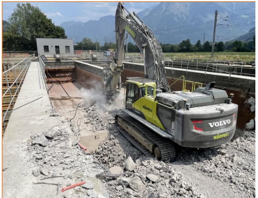
Rückbau der beiden Nachklärbecken
