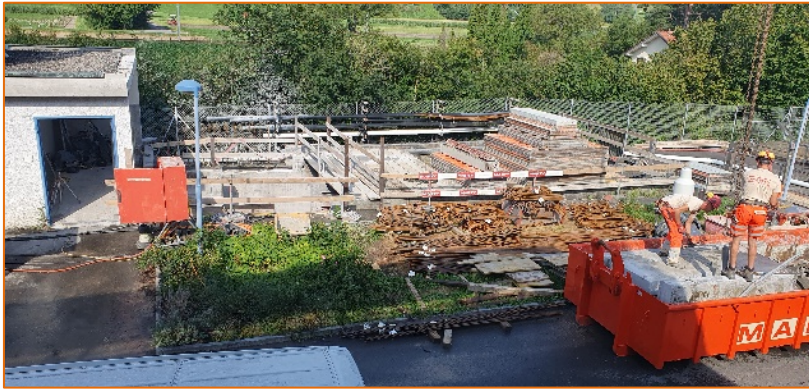
Baustelle Pumpwerk ARA Wartau.
