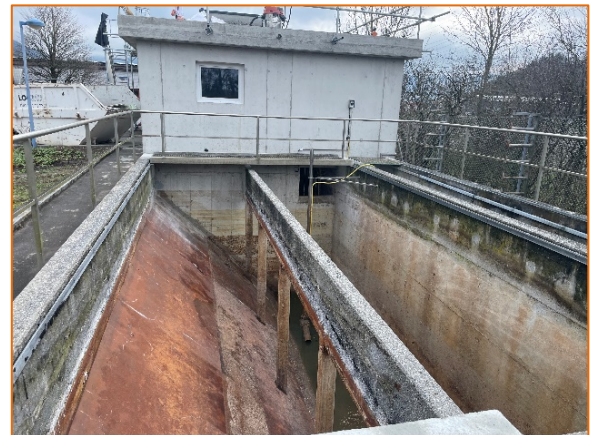
Im Hintergrund das Pumpwerk ARA Wartau mit Speicherbecken (vorher Sand-Fettfang).
